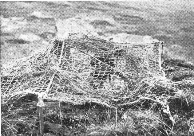
Getarnter Kp.-K.P.; trotz der spärlichen Grasauflage auf dem Tarnnetz zufolge des ansteigenden Hintergrundes für Erdbeobachtung schwer sichtbar... (Zens.-Nr. VI Vi 11630.)
