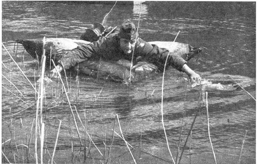
Linienbau mit Hilfe eines Zeltbahnfloßes. (Z.-Nr. III Gr 6340.)
