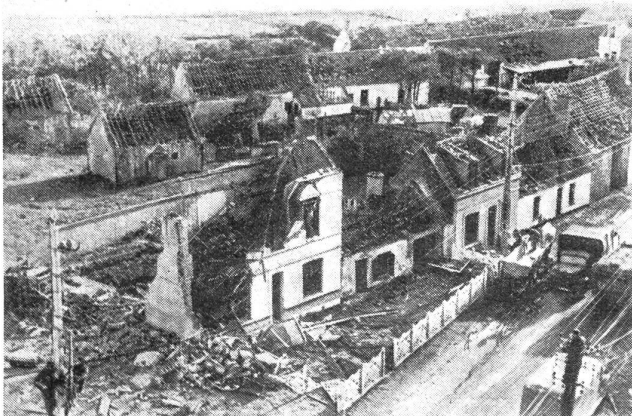
Druck- und Minenwirkung einer schweren Sprengbombe in einem Wohnquartier. Der starke Luftdruck drückte die Dachziegel ins Innere der Häuser, während das Dachgerippe vielfach bestehen blieb. Die Sprengbombe erzeugte keinerlei Brandwirkung.
