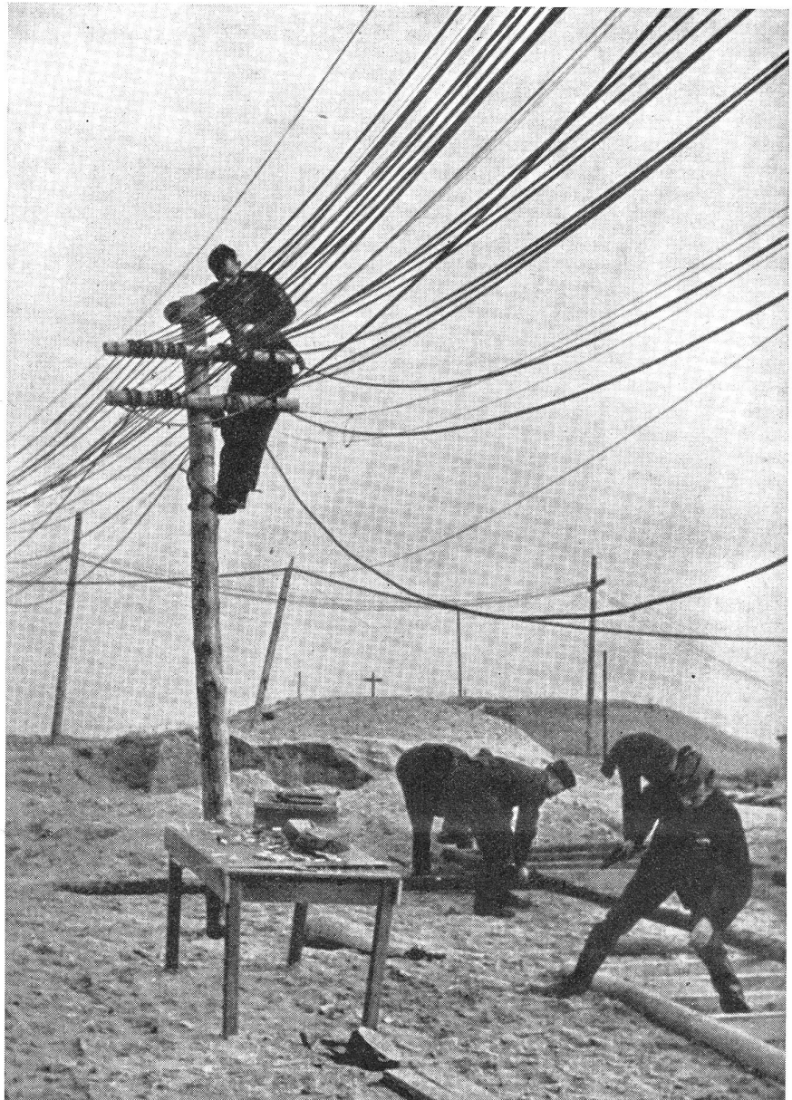
Soldaten der Nachrichtentruppe der deutschen Luftwaffe beim Bau permanenter Leitungen in einem Küstengebiet.
