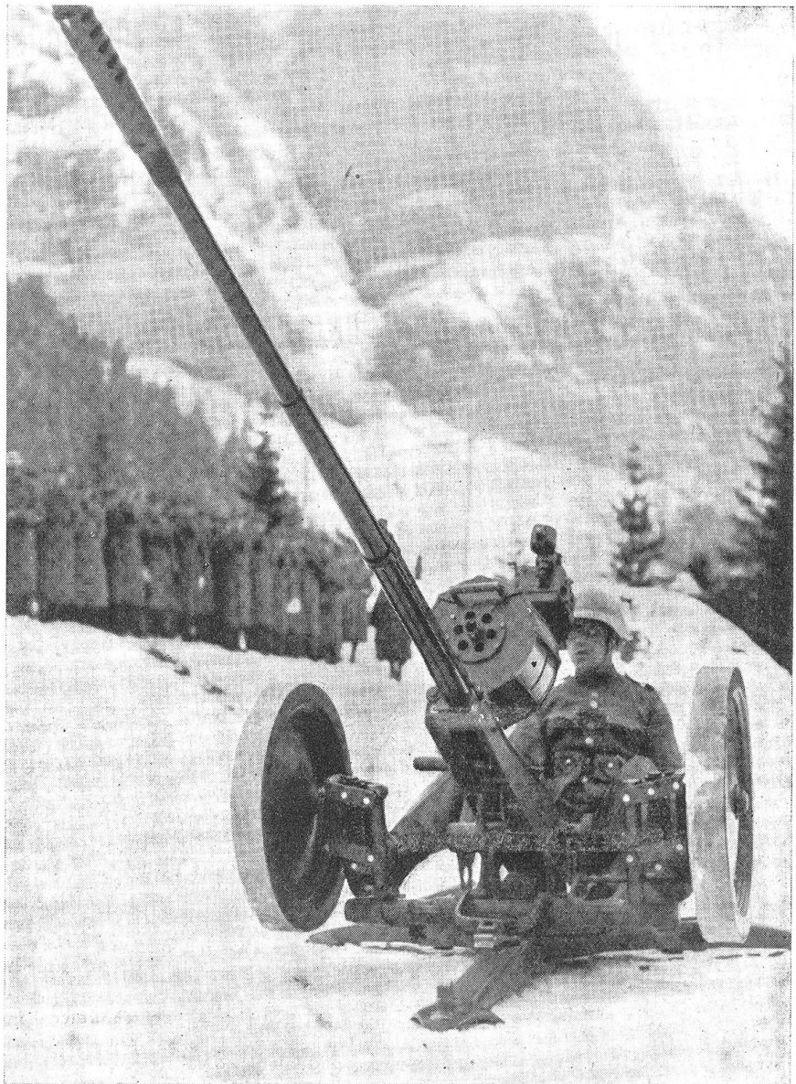
Die Flak-Kanone 43 in Feuerstellung gegen Luftziele. Vorne an der Mündung erkennt man die Schußbremse. Vor dem Trommelmagazin ist über dem Rohr das Gasdruckrohr montiert. Hinter der Trommel wird das Zielgerät sichtbar, durch das der Schütze den Flieger direkt anvisiert. Der ganze Schlitten mitsamt dem Fahrgestell läßt sich um 360 Grad drehen. Mit dem linken Pedal löst der Kanonier den Schuß aus. (N/V 13942.)
