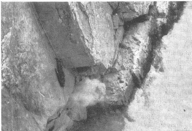
Anbringen einer Sprengladung an einer Felscharte. Aufnahme nach der Explosion. Deutlich ist das mit dem Doppelknoten um den Körper führende Sicherungsseil und die zweite Sicherung mit der Fußschlinge zu sehen.
