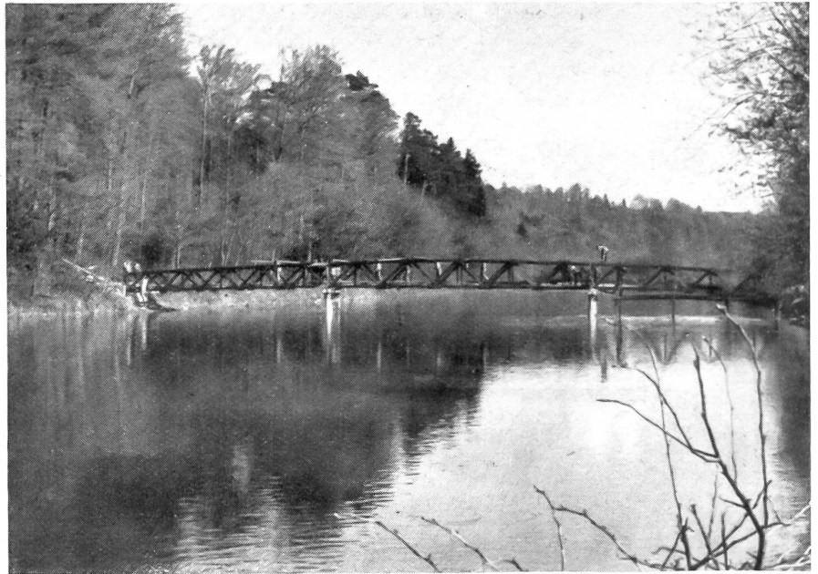
Freunde des beschaulichen Wanderns wissen um die Schönheit der Sihl und seiner Ufer, die gerade in diesen Frühlingstagen wieder recht verlockend sind. — Der neue Steg über die Sihl.
