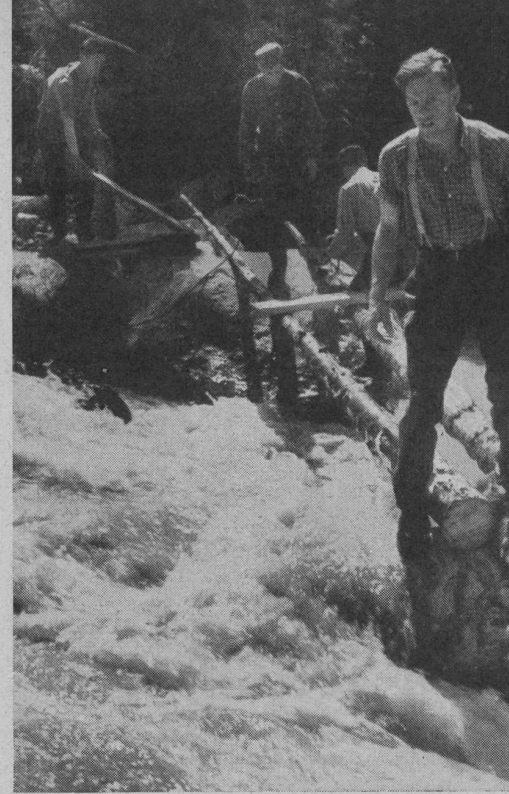
Ueber die reiÙende Flut der entfesselten Lùtschine wurden von Stein zu Stein Stämme und Uebergänge gelegt. Sie dienten der Verankerung der Verdämmungen und dem Transport des Kompressorenkabels der Bohrhämmer, mit denen die Sprengung einzelner, die Wasser ablenkender Felsen vorbereitet wurde.
