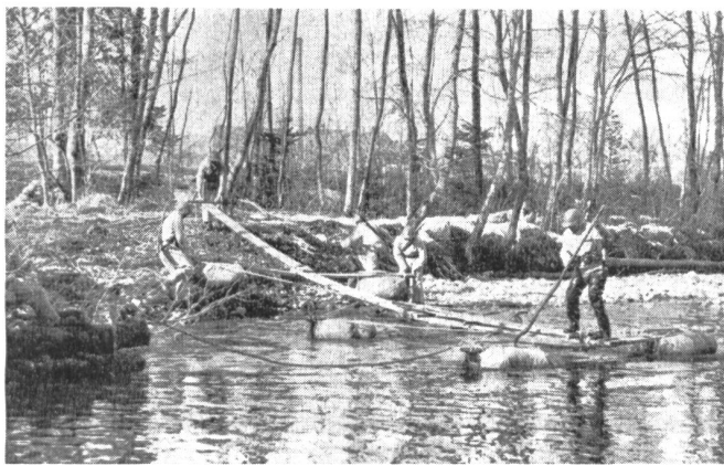
Zeltsacksteg über die Emme. Gebaut: Gren.-Kp. 15 im WK 1953.
