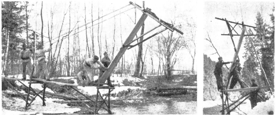
Einbau des Klappsteges dch. Gr.-Kp. 15 im WK 1953 über die Emme. Einbau des Klappsteges.
