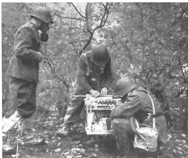
Mit Hilfe eines kleinen tragbaren Feldlaboratoriums kann die C-Equipe, bestehend aus speziell ausgebildeten Kampfstoffchemikern, im Felde Proben auf chemische Kampfstoffe untersuchen.
