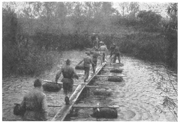
Uebergang auf behelfsmäßigem Steg (Zeltplache, gefüllt mit Stroh und verbunden mit Brettern usw.).
