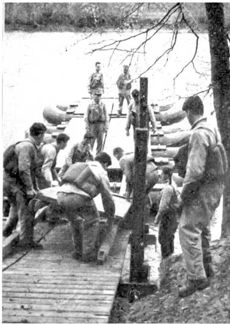
Bau eines Schlauchbootsteiges.
