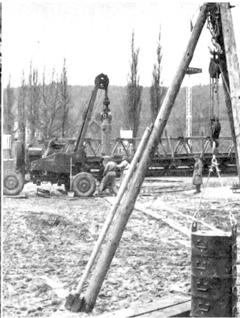
Arbeit mit dem Erdbohrgerät.
