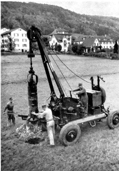
Erdbohrgerät im Einsatz.
