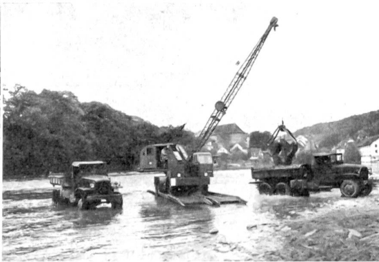
Holzbearbeitung mit Benzinkettensäge. Kiesgewinnung für den Straßenbau mit Kranwagen als Bagger in der Aare.
