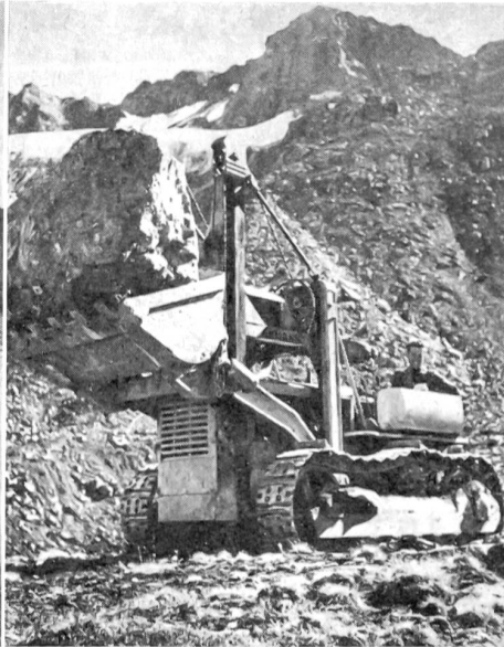
Ladeschaufel beim Straßenbau im Gebirge.
