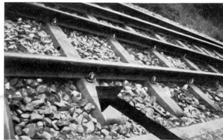
Sabotage! Schläge die Schraubenköpfe mit einem Vorschlaghammer weg
