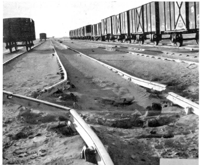
Gesprengtes Eisenbahngeleise
