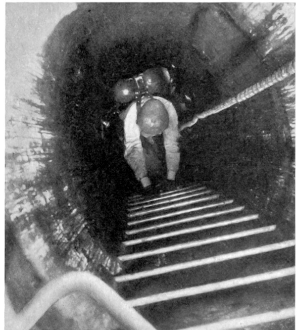
Flamm-Schütze beim Aussteigen aus dem Kanalisations-Einsteigschacht. Die Tiefe der Schächte schwankt zwischen 3 und 20 Meter.
