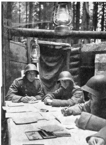
Kaum ist der Kommandoposten eingegraben, hat auch schon die Nachrichtenequipe die Arbeit aufgenommen. Sappeure erstellen erst noch das schützende Dach.
