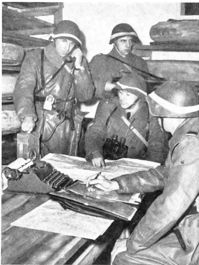
Die Zeit, als die Kommandoposten den «Sternen», «Löwen», «Bären» oder andern Namen aus dem Tierreich nachgingen sind vorbei. Die Kommandoposten haben sich heute atomsicher und dezentralisiert in Kellern einzurichten. Hier der KP eines Bataillons in einem Käsekeller in Hergiswil
