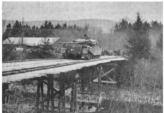
Von Genietruppen gebaute feste Brücke.
