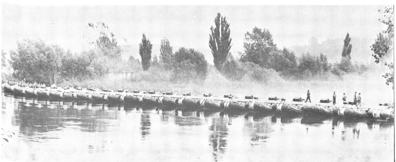
Die fertige 50-Tonnen-Schlauchboot-Brücke
