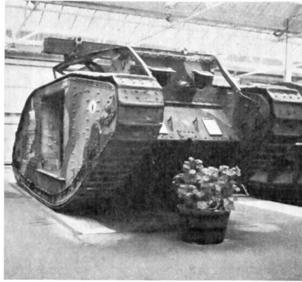
Veteran aus dem 1. Weltkrieg. Höchstgeschwindigkeit 7,6 km/h. Bewaffnung: 3 MG.
