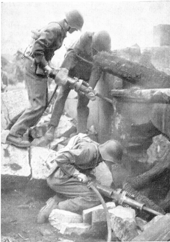
Luftschutztruppen im Einsatz
