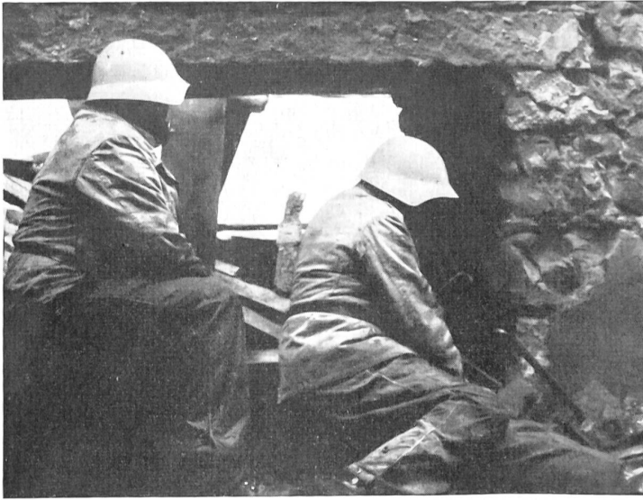
Nach den brennenden Trümmern stellen sich die ersten Hindernisse in den Weg, wie grosse Balken und Bretter, Stahlträger und Mauerwerk, welche die Durchgänge versperrern und weggeräumt werden müssen.
