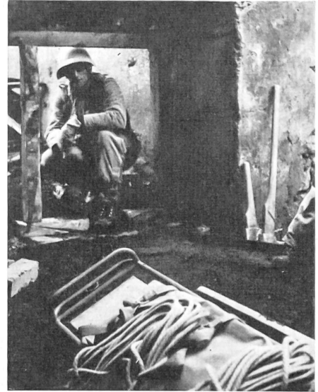
Von Trümmern befreite Durchgänge werden sauber mit zurechtgesägten Balken abgestützt, damit sie für den Nachschub und den Rückzug gesichert erhalten bleiben und kein Mauerwerk nachstürzt.
