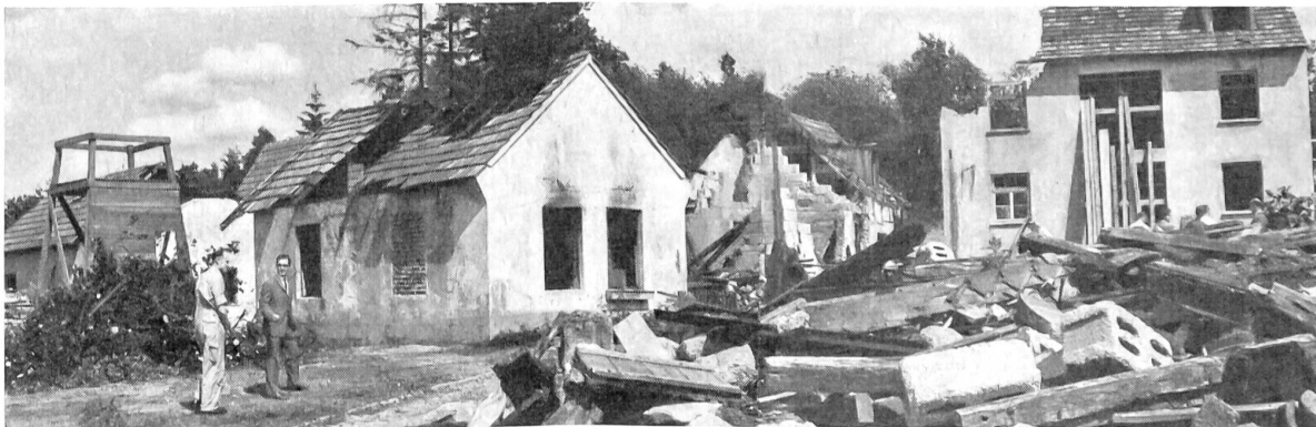
Die Anlage des Ruinendorfes der Ausbildungsstätte in Waldbröl, die alle Schadenelemente einer Katastrophe aufweist und die entsprechende Ausbildung zuläßt.
