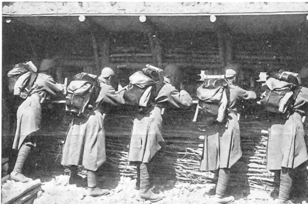
Splittersichere Feuerstellung für die Infanterie. Die solide Arbeit, die hier die Sappeure geleistet haben, flößte den Infanteristen ein Gefühl großer Sicherheit ein. Gewehr- und Maschinengewehrfeuer konnten solchen Unterständen wenig anhaben, erst nach gründlicher Bearbeitung durch die Artillerie wäre es möglich gewesen, in solche Stellungen einzubrechen.
