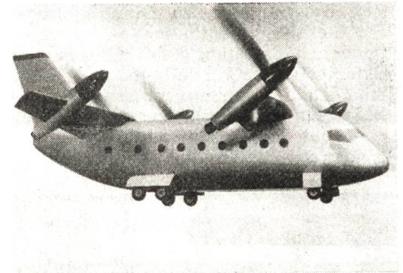
Modell des projektierten deutschen VTOL-Transporters VC 400 in der Transitionsphase.
