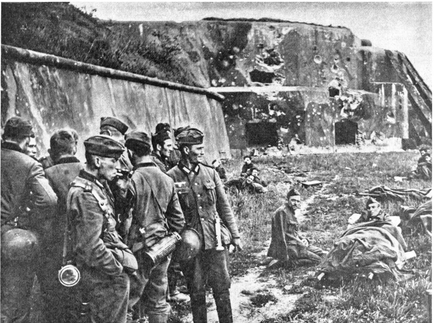
Artilleriewerk Eben Emael. Nahaufnahme von Objekt 16, «Grabenstreiche». — Erdgeschoss links: Scharte für Pak 6 cm. Rechts: Scharte für Mg. — 1. Stock links: Scharte für Scheinwerfer. Rechts (kleines Loch): Scharte für Beobachter bzw. Feuerleitung. — Vorne sitzend und liegend: Gefangene Belgier, zum Teil verwundet. Vorne stehend: Deutsche Soldaten vom verst Inf Regiment 151.
