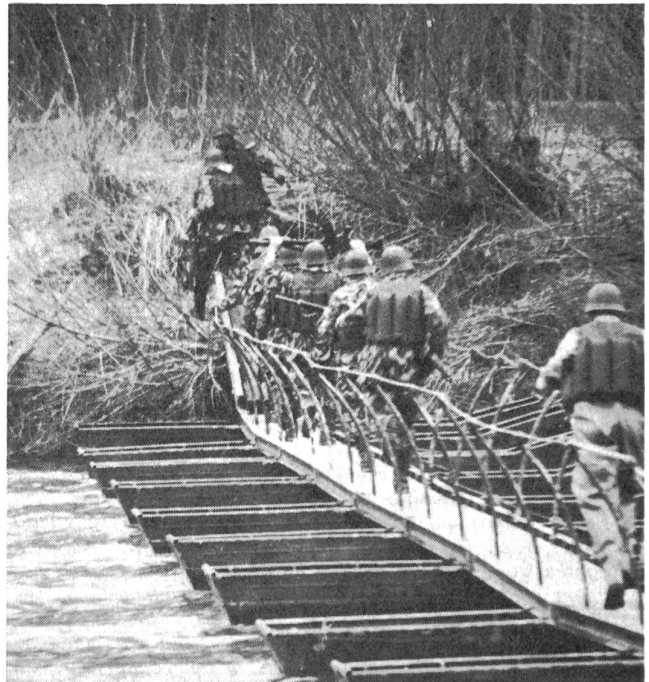
10 Minuten 30 Sekunden: Der Zug hastet über den fertig eingebauten Steg.
