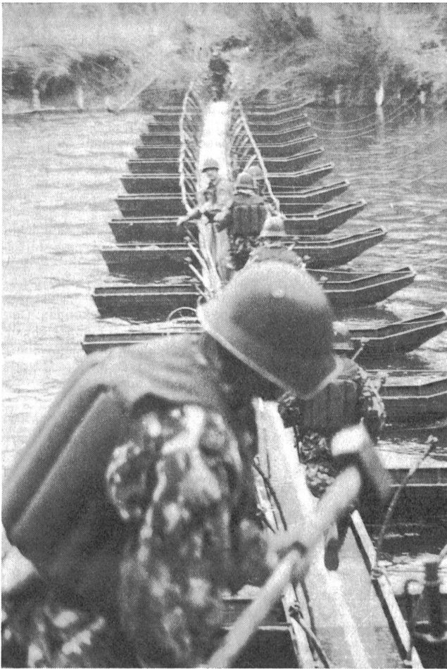
10 Minuten sind verstrichen. Der Steg stösst am anderen Ufer an. Rasch werden der Ein- und Ausstieg montiert.
