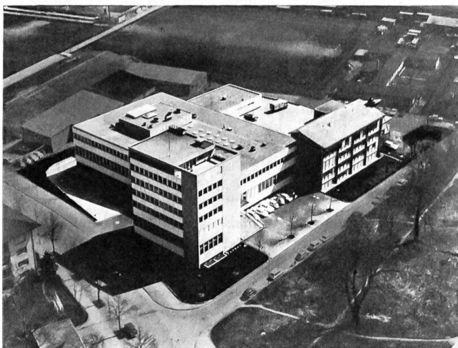
Das Zentrallaboratorium des Blutspendedienstes des Schweizerischen Roten Kreuzes verfügt über einen grosszügig konzipierten Neubau. Rechts aussen befindet sich der 1952—1954 erbaute Altbau.
