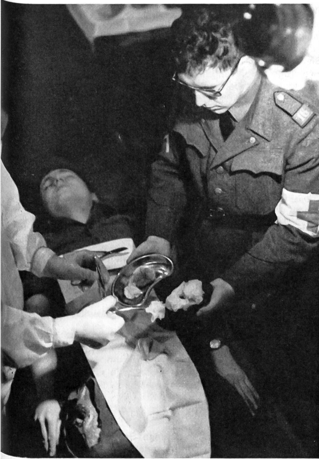
Die Sanitätshilfsstelle (der Ort der ersten ärztlichen Behandlung) ist in einem geschützten Keller eingerichtet
