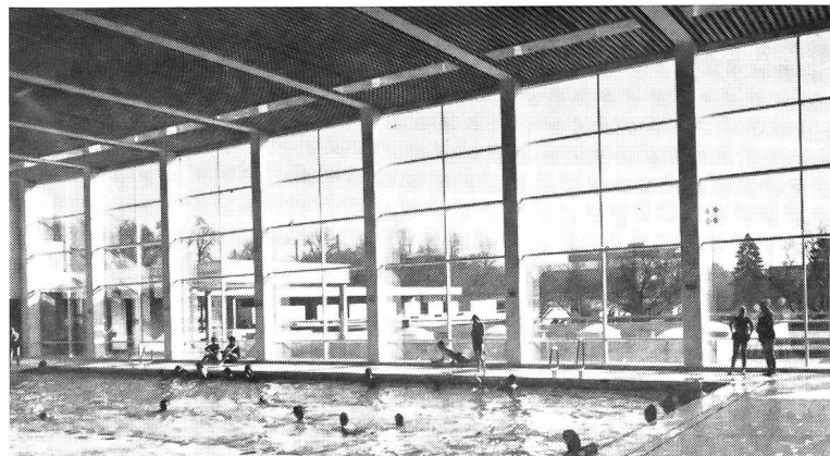
Jansen-VISS-Profile ermöglichen extrem schlanke Sprossen mit unterbrochener Kältebrücke, wie diese Aufnahme vom Hallenbad Weyermannshaus in Bern zu beweisen vermag.
