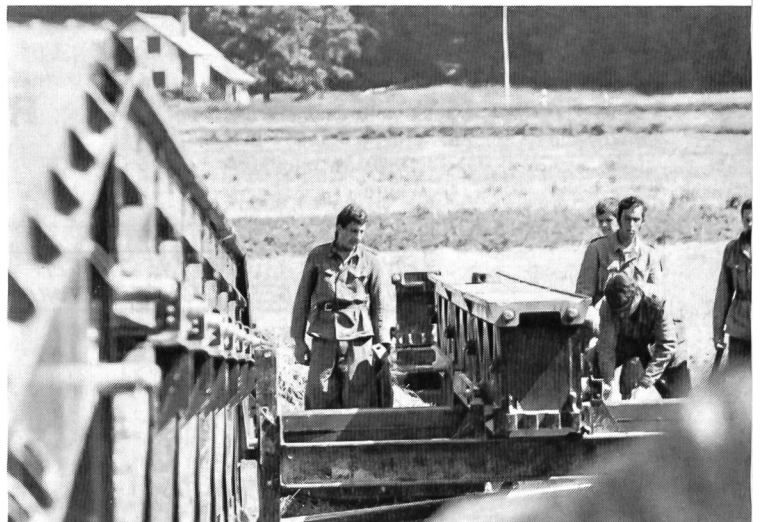
Der Vorbauschabel wird am gegenüberliegenden Ufer abgebaut.
