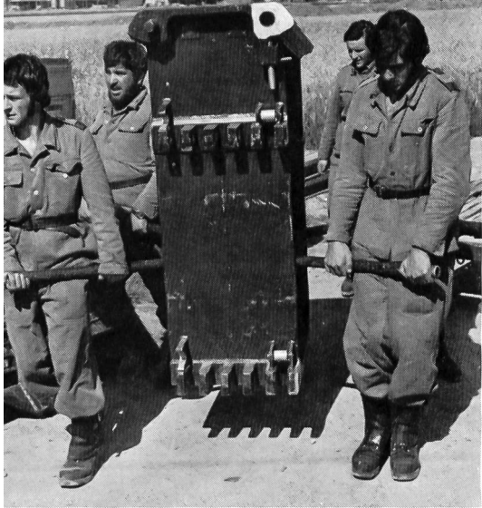
Der Trapezpfosten, der den Abschluss der Rampe bildet
