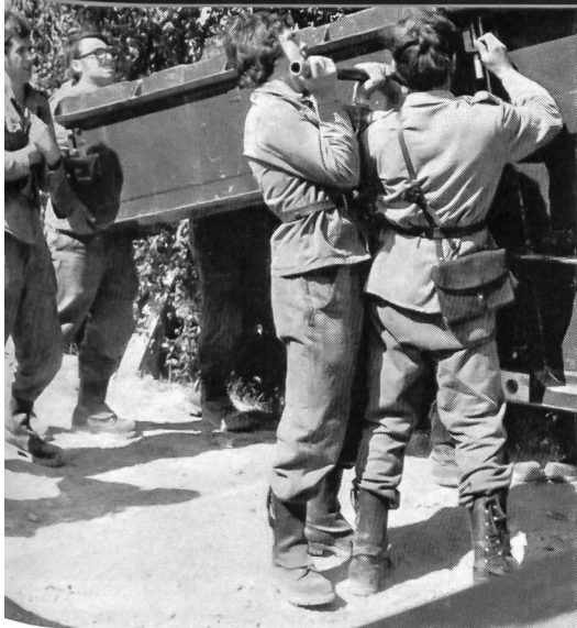
Brückende: Die Rampe am Einbauufer wird erstellt.
