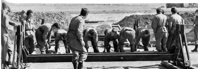
Bau des Montagegestells
