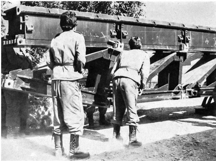
Einbau eines Fachwerkelementes
