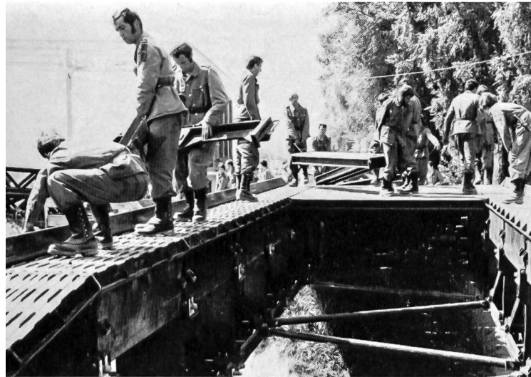
Einbau der Fahrbahnplatten und Randbleche
