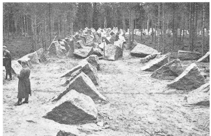
Mannerheimlinie. Finnisches Panzerhindernis aus Granitblöcken.
