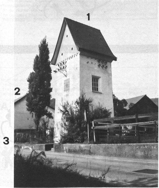
1 Trafostation, Blick auf Süd- und Westfassade, im Vordergrund die Dorfstrasse 2 Südfassade des Gebäudes Nr. 31 3 Auf dieser Strassenseite (nicht sichtbar) das Gebäude Nr. 30 (Hohes Haus)
