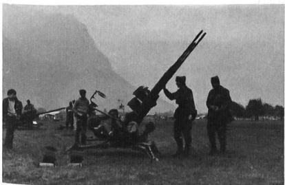
20-mm-Drilling mit manueller Steuerung für den Flugplatzschutz gegen feindliche Fliegerangriffe. Wirkungsbereich etwa 1500 m.
