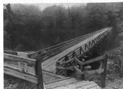
Eine saubere, sinnvolle WK-Arbeit: Der 95 m lange und 4,4 m breite Fussgängersteg über die Reuss, im sogenannten Dominiloch, wenig oberhalb vom Frauenkloster Hermetschwil.
