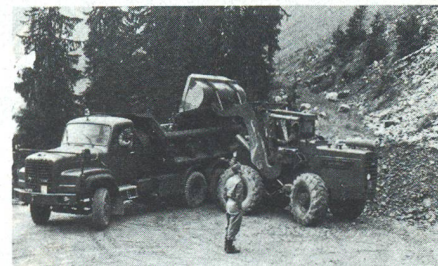
Einsatz der Baumaschinen im Suldtal.
