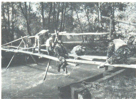
Aspiranten beim Stegbau.
