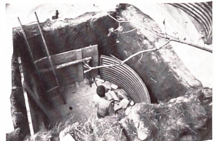
FIBM Posten im Bau
