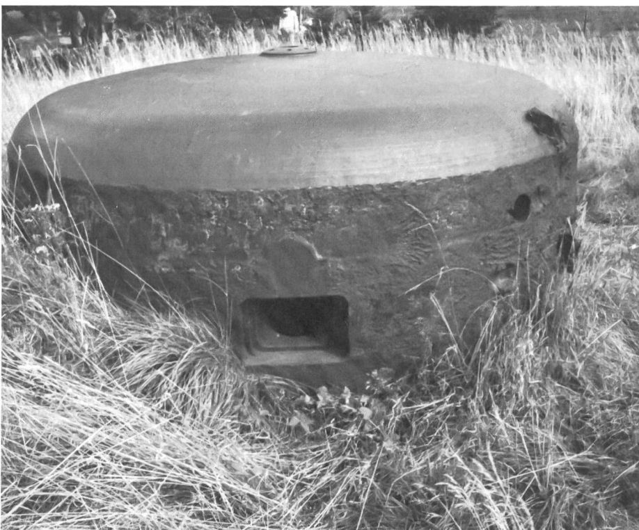
Abb. 6 Sechsscharten-Panzerturm für gleichzeitigen Einsatz von zwei Mg 34, weder drehbar, noch versenkbar.
