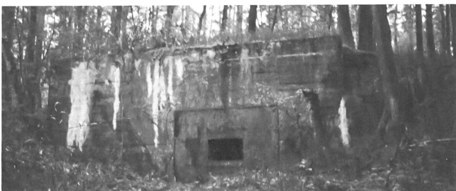
Abb. 5 Gruppenunterstand Limes Regelbau-Typ Nr 10, Hauptscharte des angehängten Kampfraumes, Schussrichtung auf HKL.
