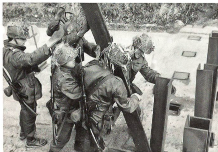
«Einrichten zur Verteidigung». Stecksperren werden an Brücken und Engstellen errichtet und durch Feuer überwacht.
