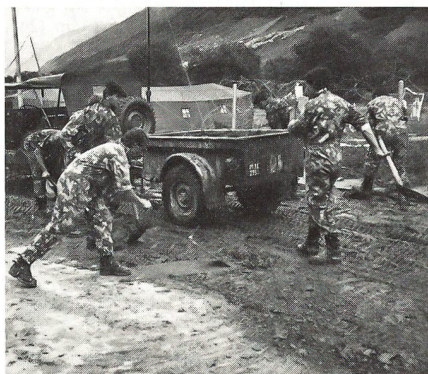
Nicht nur Maschinen halfen Schäden beheben, auch mit Schaufel und Pickel wie hier in Realp halfen Wehrmänner mit. Dank der entsprechenden beruflichen Ausbildung konnten Wehrmänner auch mit zivilen Baumaschinen Hand anlegen.
