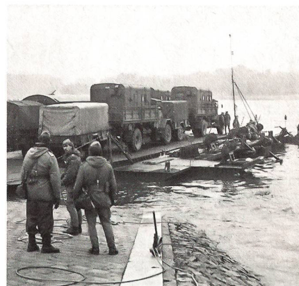
Mit Kriegsbrückengerät – im Bild als Fähre – sind die Schwimmbrückbataillone des TerrHeeres ausgerüstet.
