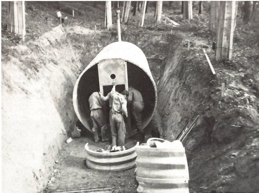
Die einfachen Montagearbeiten. Mit einem Bulldozer oder einem ähnlichen Gerät kann der Shelter in kürzester Zeit mit der ausgehobenen Erde wieder zugedeckt werden.
