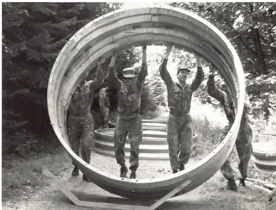
Die Elemente aus Stahl werden bereitgestellt.
