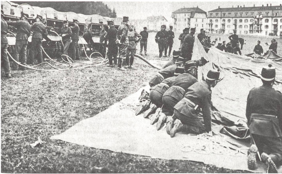
Die Ballonkompanie 1916 in Holligen bei Bern. Füll- und Blachentrupp an der Arbeit. Links fahrbare Gaserzeuger.
