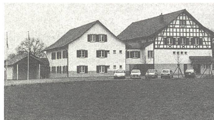
Werkhaus Oberstammheim am südwestlichen Dorfrand – rechts Altbau, links und Mitte Erweiterung
