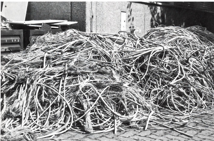
Unzählige Kilometer Telefonkabel sind in der elektromechanisch gesteuerten Fernmelde-Zentrale Breitenbach (SO) überflüssig geworden. Ein Detachment der TT-Betr Kp 21 ad hoc hat sie ausgebaut.
