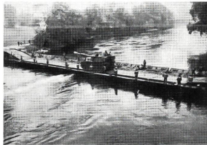
Fertig eingebaute Schwimmbrücke 95.
