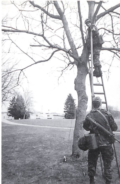
Telefonleitungsbau: Hochbau mit Linienstange.
