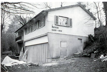
Das Depot der Pontoniere von Ellikon wird in Fronarbeit umgebaut und erweitert.
